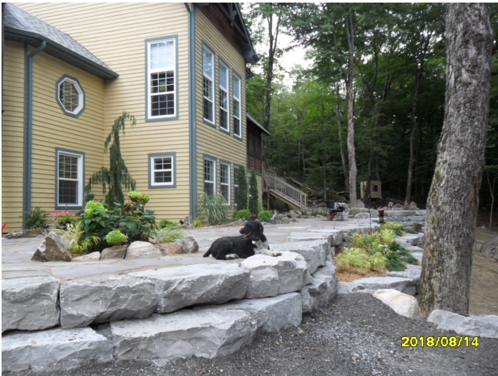
Photo no. 2 : rue Du Parc, Cantley, Québec
